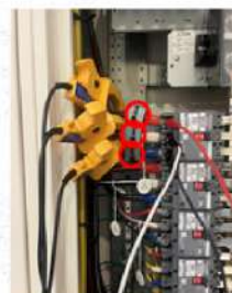
エスカレーター3号機計測中
